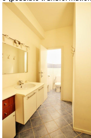
WC séparé (possible transformation en SDB) :
